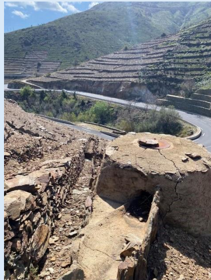
Figure 14 : Photo prise dans les Pyrénées Orientales, sur une parcelle avec des aménagements hydrauliques favorisant la collecte des eaux de pluie. Visite d'une parcelle à Banyuls-sur-mer en mars 2024
