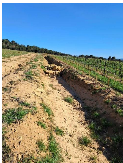
Figure 20 : Fossé en amont de la parcelle pour ralentir l'eau, lui laisser le temps de s'infiltrer et l'évacuer pour éviter l'érosion. Source : photo personnelle
